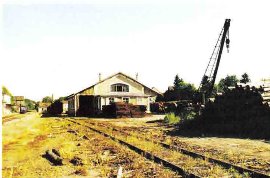
De houtopslag, waar het ooit allemaal om begonnen was. Links is nog het perronspoor van Corbigny zichtbaar.
